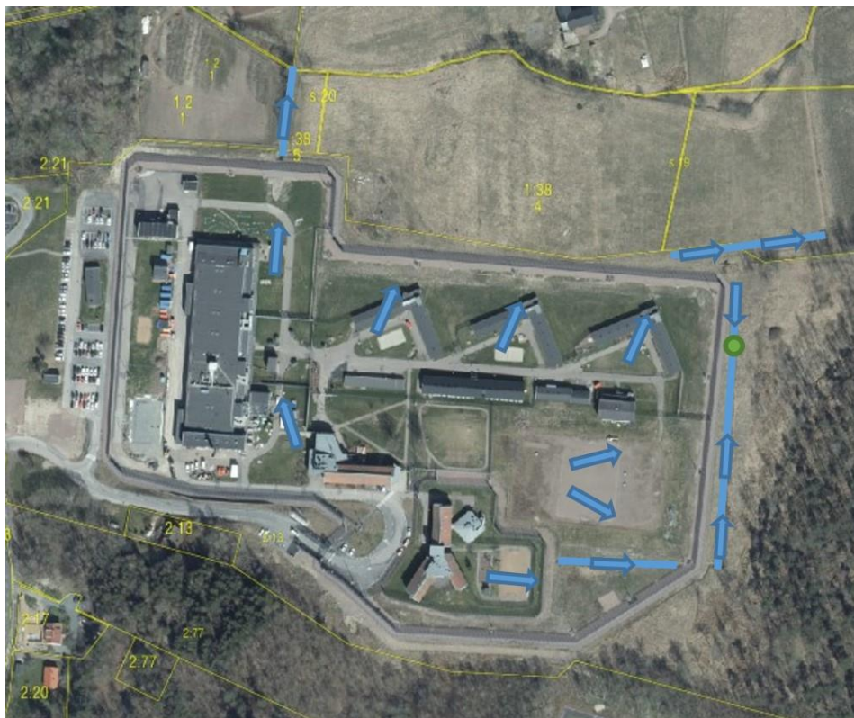
Figur 4. Identifierade diken, brunn samt avrinning från platsbesök.
